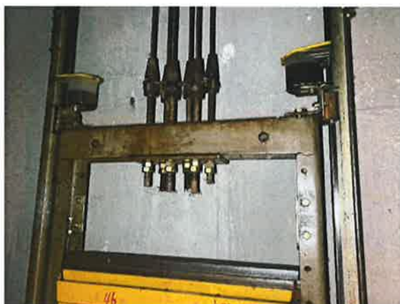
图 14：绳头组合无弹簧缓冲装置
