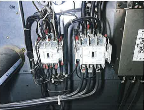
图 5：LB 和 5#接触器已更换为非原装接触器
