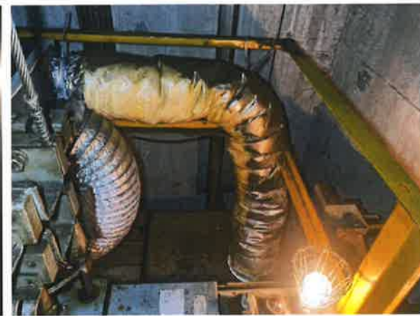
图 12：轿顶护栏设置不符合现行标准
