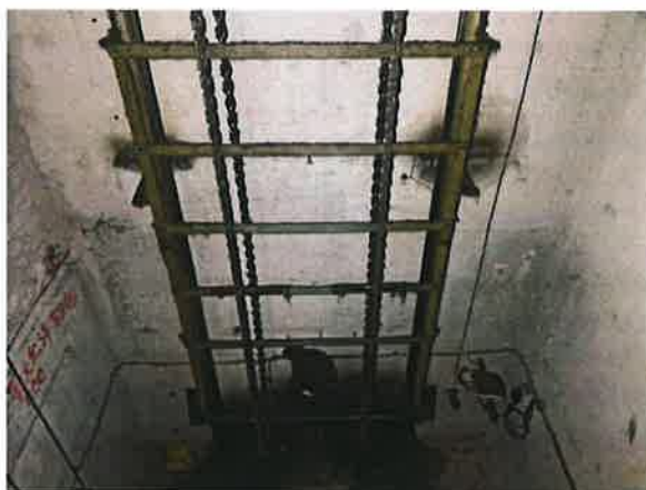
图 16：底坑对重运动区域防护不符合现行标准
