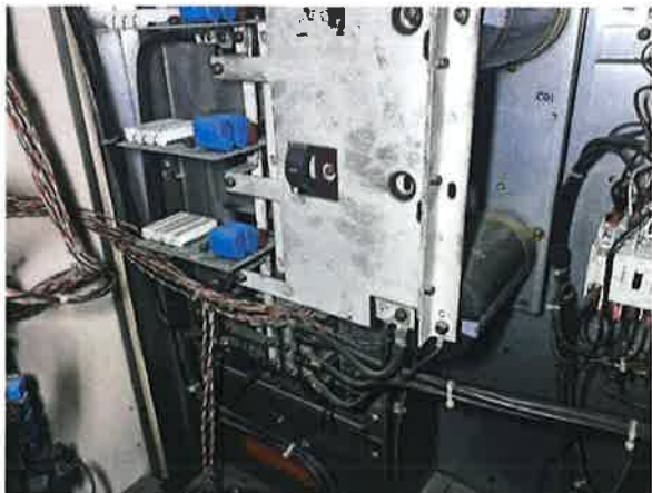
图 6：调速装置的驱动电子板老化
